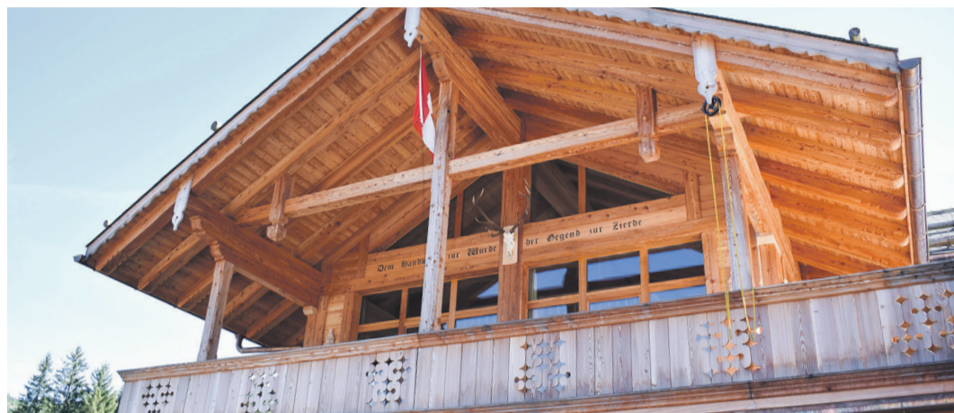
Das Wohnhaus wurde hauptsächlich aus Lärche als traditioneller Holzbau/Riegelbau erstellt.
